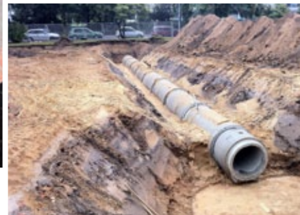
Regenrückhaltung Betonrohre DN 2000
